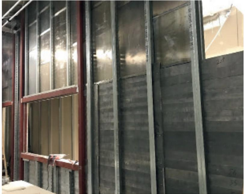
Strahlenschutzwand mit Bleisteinen (hier mit Pb 28,0 mm)
