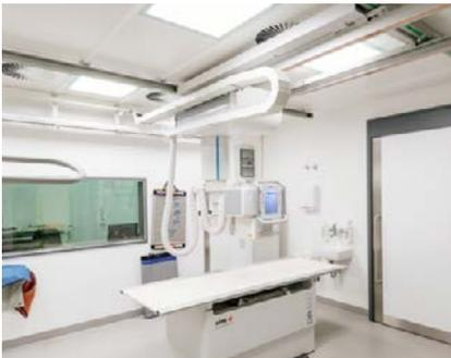
Das Profilsystem zeichnet sich durch eine hochwertige Konstruktion aus, die flexibel je nach Geräteanforderung anpassbar ist. Darüber hinaus ist jederzeit eine Umrüstung (Nutzungsänderung) nach technischer Überprüfung möglich, ohne die gesamte Deckenkonstruktion ändern zu müssen.
