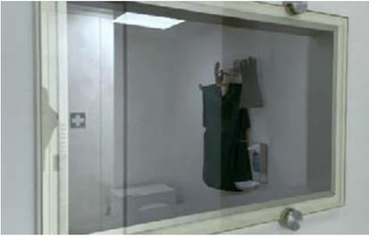
Zwischen Patient und Bedienpersonal muss in Behandlungsräumen ein Sicht- und Sprechkontakt bestehen. In Wänden und Türen können mit Strahlenschutzgläser Durchsprehöffnungen gebaut werden. Das Glas wird vor der Tür bzw. Wand montiert. Es muss eine entsprechende Überlappung zwischen Wand bzw. Tür und dem Strahlenschutzglas berücksichtigt werden, damit der Strahlenschutz gewährleistet ist (>50 mm). Hier steht ein entsprechendes System zur Verfügung.
