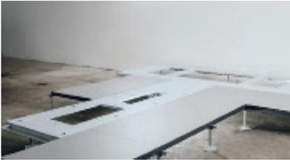
Auch in Doppelbodenflächen können Stahlplatten eingebaut werden, um später zum Beispiel einen CT mit Patiententisch zu betreiben. Hier sind besondere statische Anforderungen zu lösen, damit die CTs bei der späteren Nutzung einwandfrei funktionieren.
