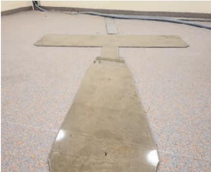
Durch das selbstnivellierende Material wird eine absolut waagerechte Bodenfläche hergestellt. Dies führt zu einer ganz erheblichen Zeitersparung beim Ausrichten und Installieren von CTs und Patiententischen.
