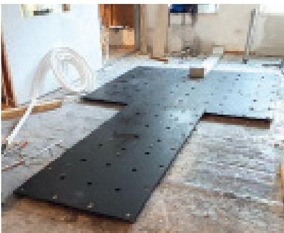
Diese Stahlplatten werden auf dem Rohfußboden montiert und später mit Beton oder Estrich ausgegossen. Es werden selbst produzierte oder vom Gerätehersteller bereitgestellte Bodenplatten verwendet. Diese werden nach der Geräteplanung im Raum ausgerichtet und montiert. Sämtliche Bohrungen für Patiententische oder Röntgengeräte werden bereits werksseitig in die Stahlplatten eingearbeitet.
