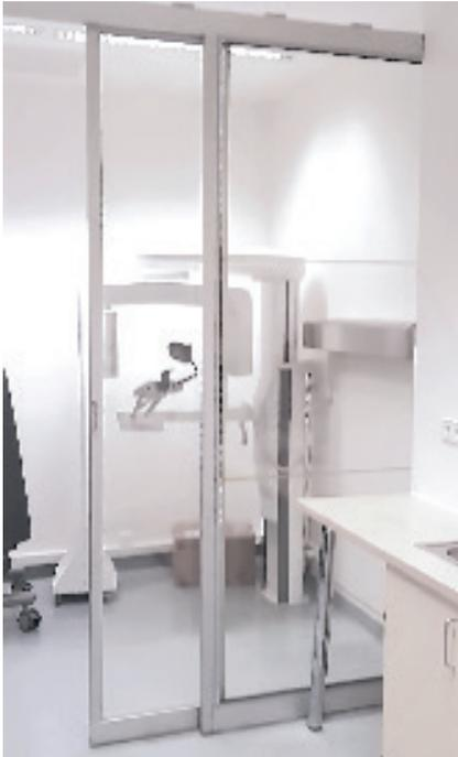
Strahlenschutz-Schiebetürelement mit festem Seitenteil als komplett transparente Lösung. Die Strahlenschutzgläser wurden mit einem eloxiertem Aluminiumprofil verarbeitet.
