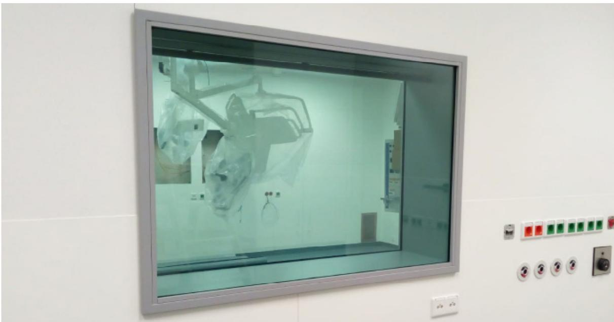
Doppelverglasung zum baubegleitenden oder nachträglichen Einbau mit elektrisch betriebenen Rollos und in Kombinationen mit Schall- oder Strahlenschutz möglich.
