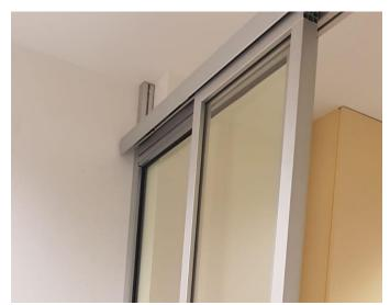
Der bewegliche Teil der Strahlenschutzverglasung läuft oberhalb in einer Metallschiene. Zum Einen ist der Bereich dahinter so komplett schwellenlos zu begehen, zum Anderen ist die Verglasung so sehr leicht und angenehm in der Handhabung.
