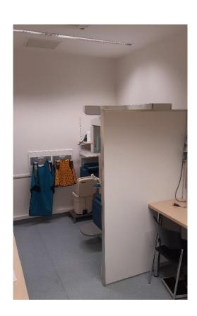
Aufgrund einer Neuinstallation eines Röntgengerätes musste dieser Raum umgebaut werden, da der Strahlenscgutz nicht mehr ausrechend war. Bei der Baubesprechung wurde festgelegt, dass die Trennwand als Strahlenschutz mitten im Raum nicht optimal ist. Durch die massive Wand wirkt dieser recht klein und verwinkelt. Eine gute Übersichtlichkeit ist so nicht gegeben.
