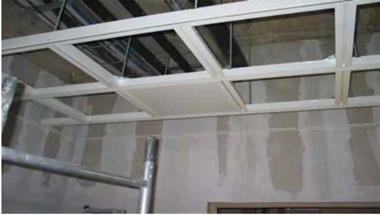
In diversen Diagnostikräumen werden Gerätelaufschienen in Längs- und Querrichtung benötigt. In diesen Fällen muss ein Kreuzraster gebaut werden, damit die Laufschienen befestigt werden können.
