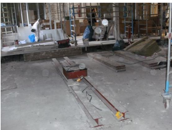
Bodenplatte auf einer lastverteilenden Unterkonstruktion
