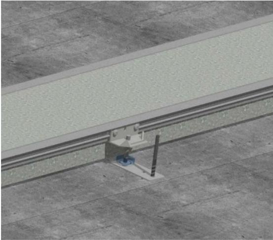
Die fertig ausgerichtete und grob ausnivellierte Kanalstrecke wird mittels Schlagdübel an den Haltepratzen auf der Rohdecke befestigen.
