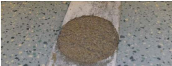
Für eine Geräteführungsschiene wird der Belag sauber entfernt. Im Befestigungsabstand der Schiene werden Kernbohrungen für eine sichere Befestigung gesetzt.
