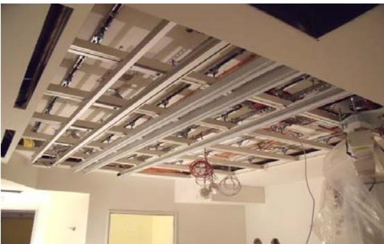
Schwerlastdecke mit Klemmkonstruktion einschließlich eines Leuchteneinbaurahmens
