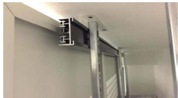
Mit variabler Unterkonstruktion ist jede Metallkassette an jeder Stelle nachträglich demontierbar.
