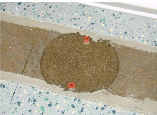
Anschließend wird die Bohrung mit einem Quarzsand/Gießharzgemisch aufgefüllt.
