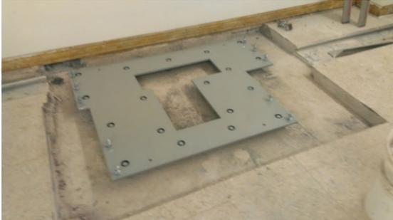
Bodenplatte aus 15/20/25 mm Stahlblech;
