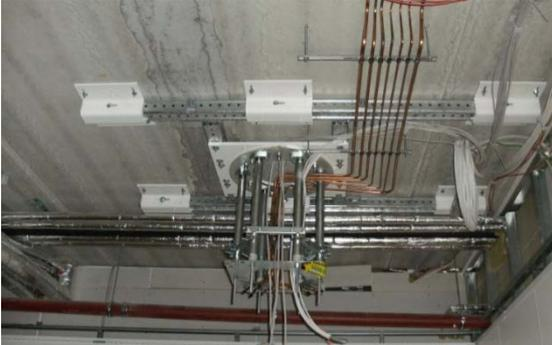
Unterkonstruktion für eine Träger-DVE-Einheit
