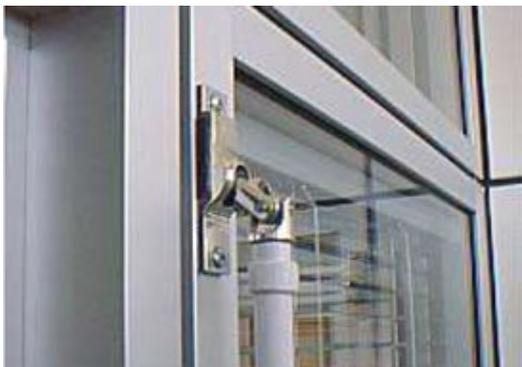
Zur Längenbestimmung der Handkurbel benötigen wir die Brüstungshöhe der Fenster, damit die Länge der Handkurbel richtig errechnet werden kann.
