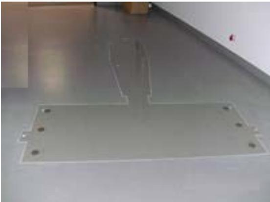
Anschließend werden die Bohrungen gesäubert, mit Gießharzgemisch aufgefüllt und bis Oberkante Estrich aufgeossen.
