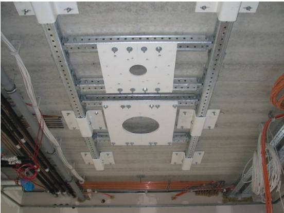
Unterkonstruktion für eine Träger-DVE-Einheit samt OP-Leuchte
