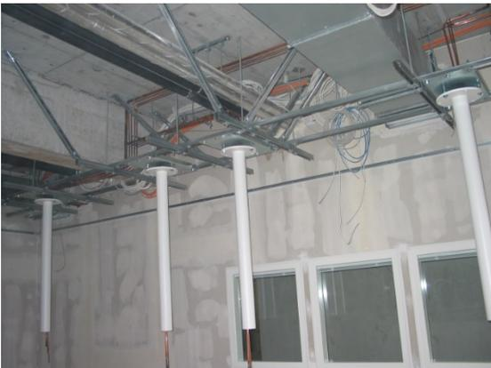
Unterkonstruktion für eine Träger-Ponta-Einheit
