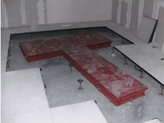
Bodenplatten aus 15/20/25 mm Stahlblech, als Einheit verbunden;
