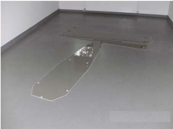
Wenn der Fertigfußboden bereits verlegt ist, kann die Kontur der Bodenabdeckung der Geräte aus dem Boden herausgeschnitten und mit Gießharz aufgefüllt werden. Damit entsteht eine flächenbündige Einbausituation.
