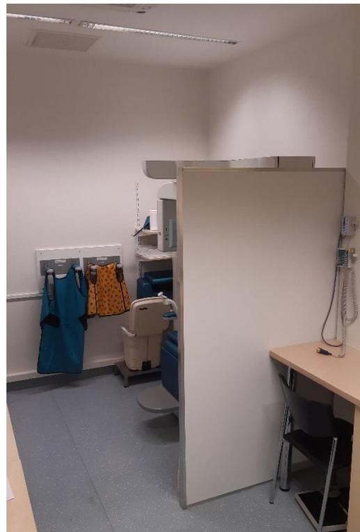
Aufgrund einer Neuinstallation eines Röntgengerätes musste dieser Raum umgebaut werden, da der Strahlenschutz nicht mehr ausreichend war. Bei der Baubesprechung wurde festgelegt, dass die Trennwand als Strahlenschutz mitten im Raum nicht optimal ist. Durch die massive Wand wirkt dieser recht klein und verwinkelt. Eine gute Übersichtlichkeit ist so nicht gegeben.
