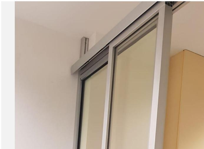
Der bewegliche Teil der Strahlenschutzverglasung läuft oberhalb in einer Metallschiene. Zum Einen ist der Bereich dahinter so komplett schwellenlos zu begehen, zum Anderen ist die Verglasung so sehr leicht und angenehm in der Handhabung.
